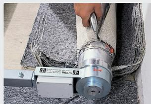
Lösen des entfernten Belages durch Auftrennen mit dem FLIPPER-Messer oder durch Abwickeln mit dem Elefant.
