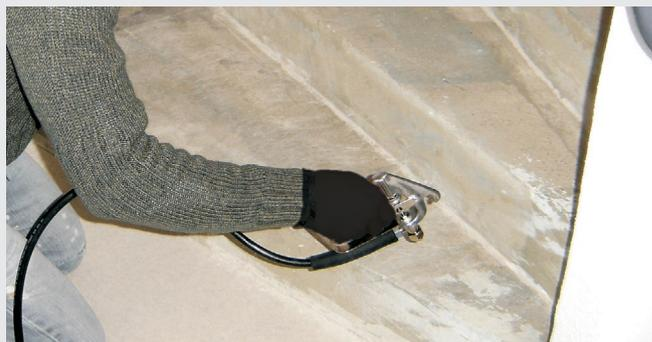
Auch auf kalten Untergründen, wie Betontreppen zu verarbeiten. Der Sprühstrahl der Pistole kann von punktgenau bis breit gefächert eingestellt werden.
